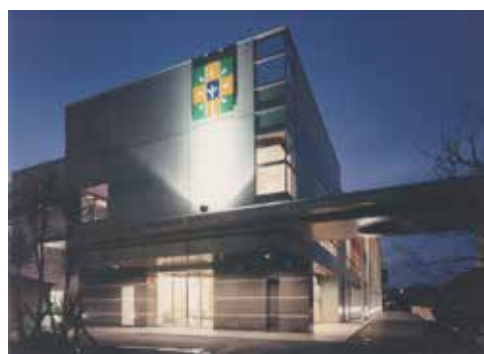
写真2 2000年竣工した新病院
